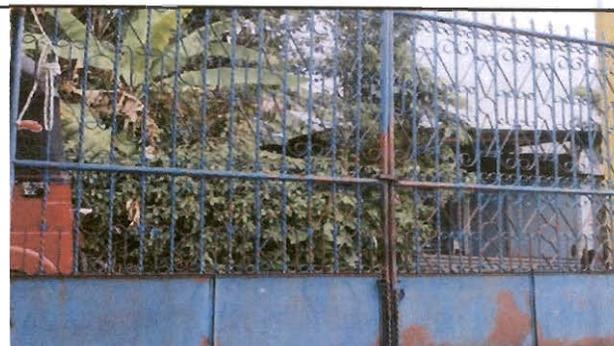
Foto12; Mantenimiento a estructura (lijado, cambio de tubo , cepillado, sujeciones, aplicación de pintura)
